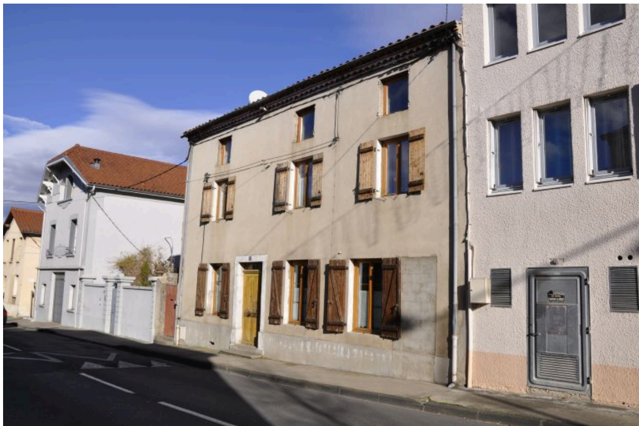
1986 AE 58, 62. 31, 27 avenue Thermale. Maison et carrosserie, vue d'ensemble des façades sur l'avenue.
