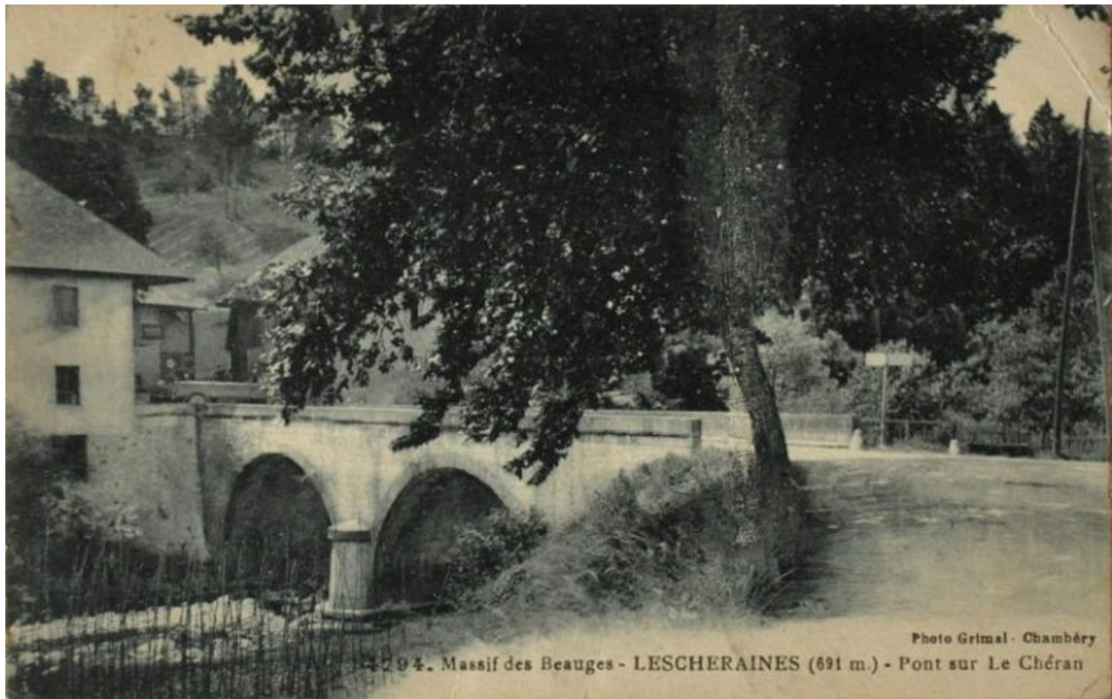
Le pont et le bâtiment de la forge (© Collection particulière M.-A. Podevin).
