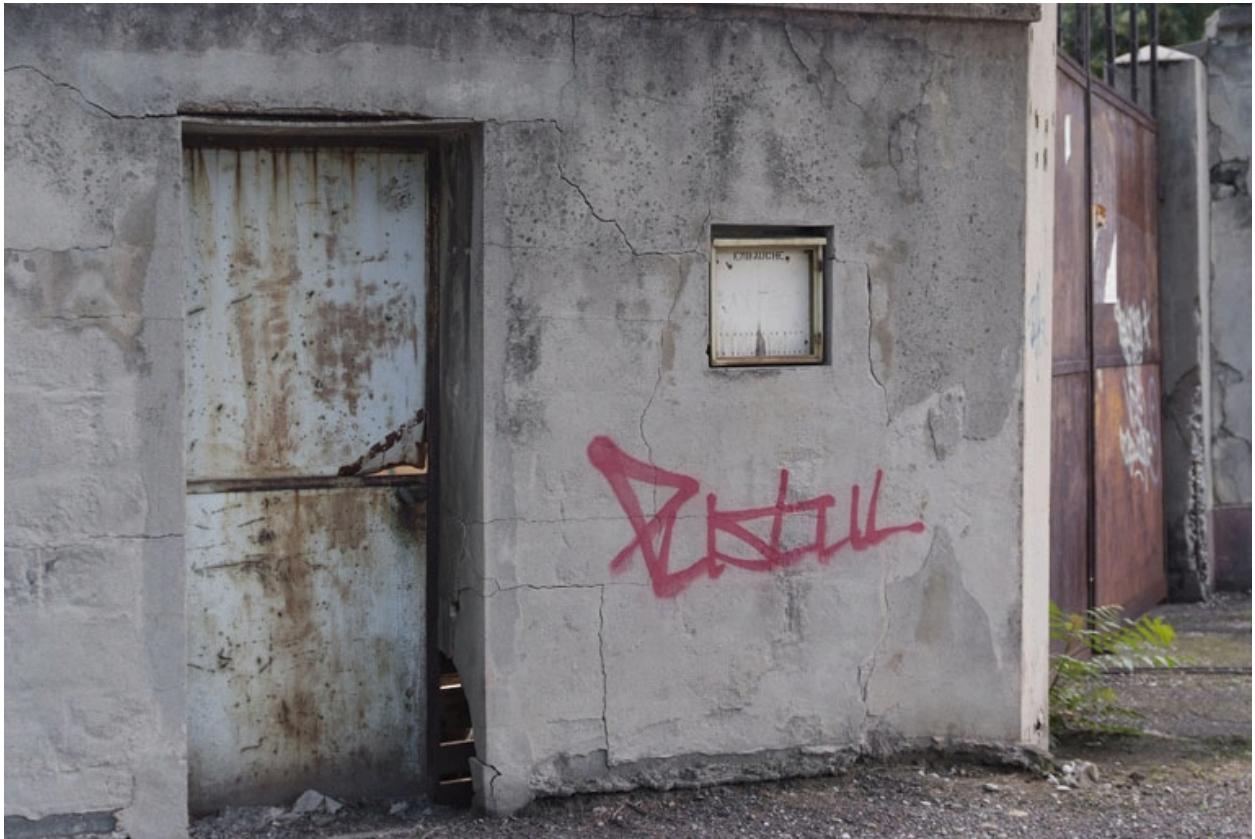
détail tableau d'embauche localisé sur une entrée latérale
