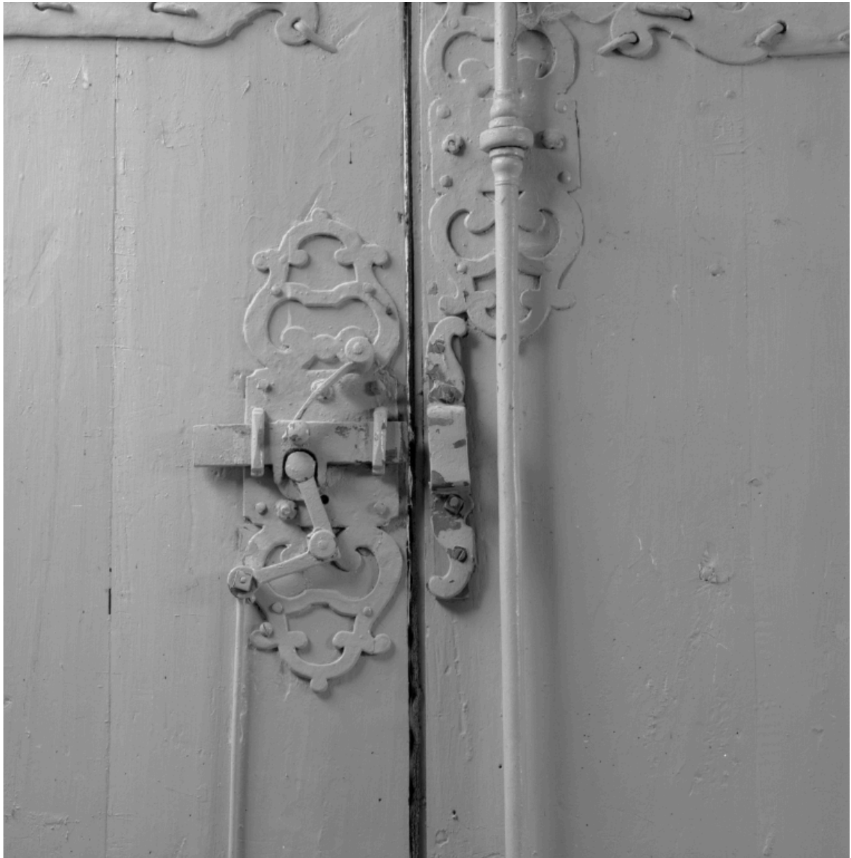
Vue intérieure : détail du verrou à renvoi.
