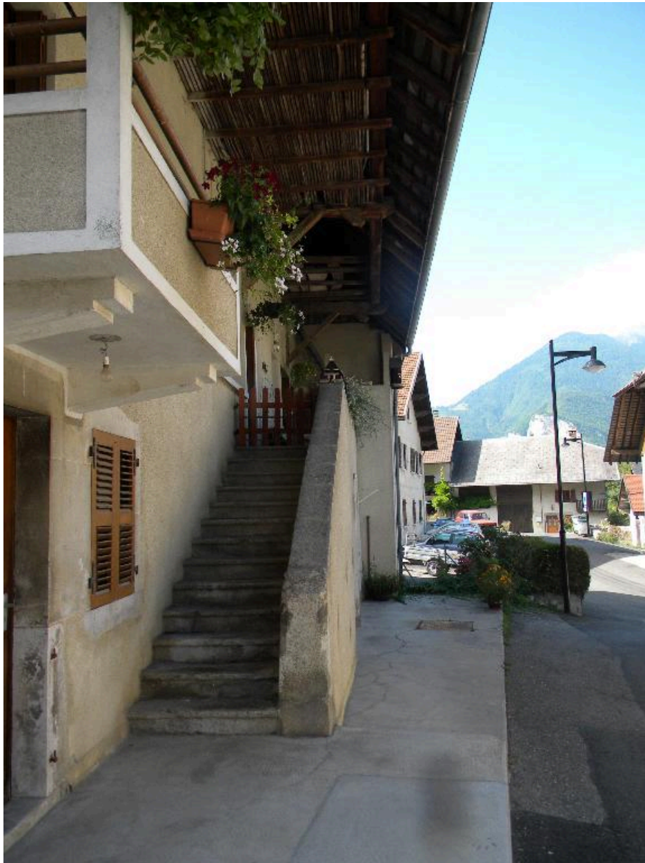
Vue de la montée d'escalier en façade d'une ferme avec balcon sur deux loges (2008 F7 861)
