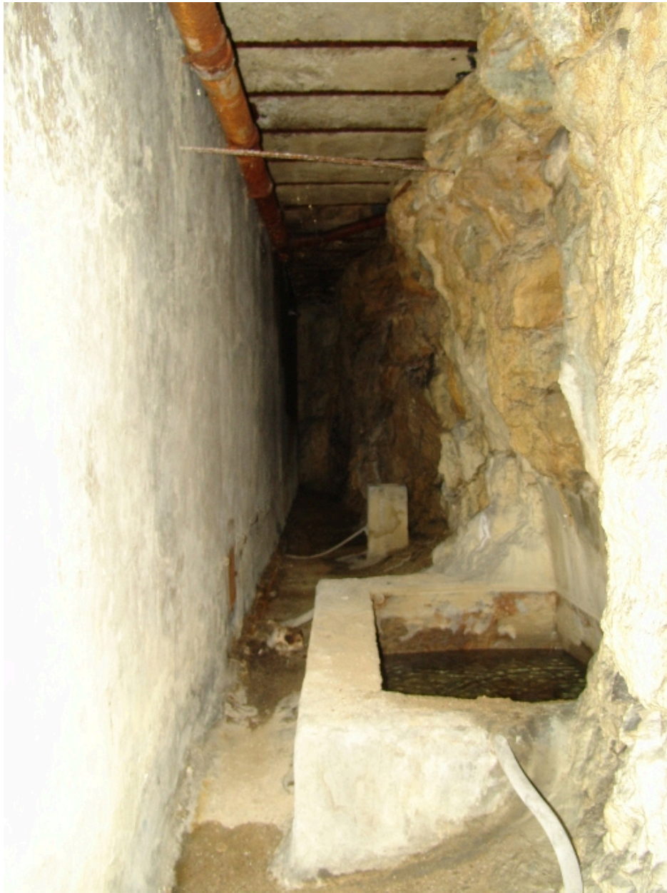
Dégagement souterrain autour de la maison
