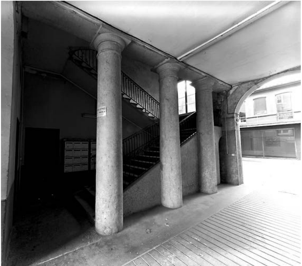
Vue d'ensemble du vestibule et de l'escalier du corps de bâtiment quai Perrache
