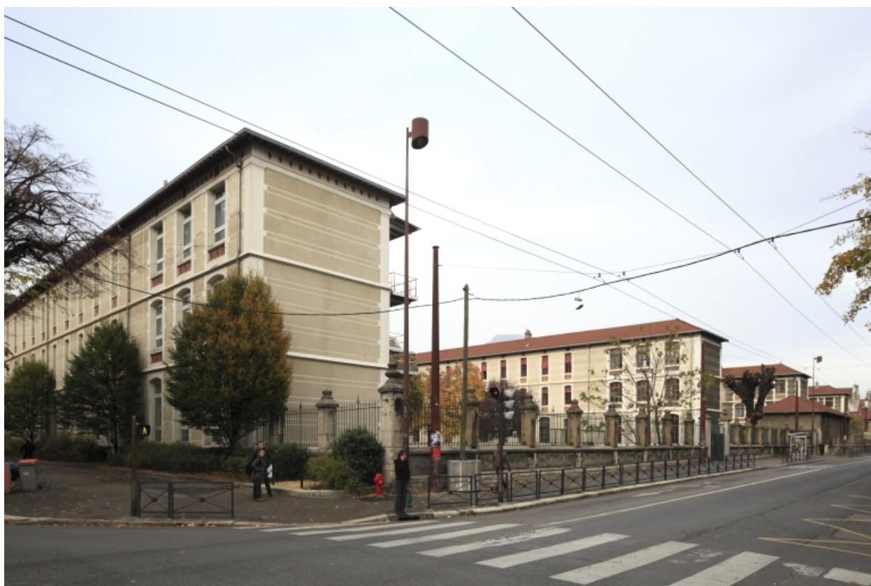
Bâtiments 'en dent de peigne' sur la rue Lesdiguières.
