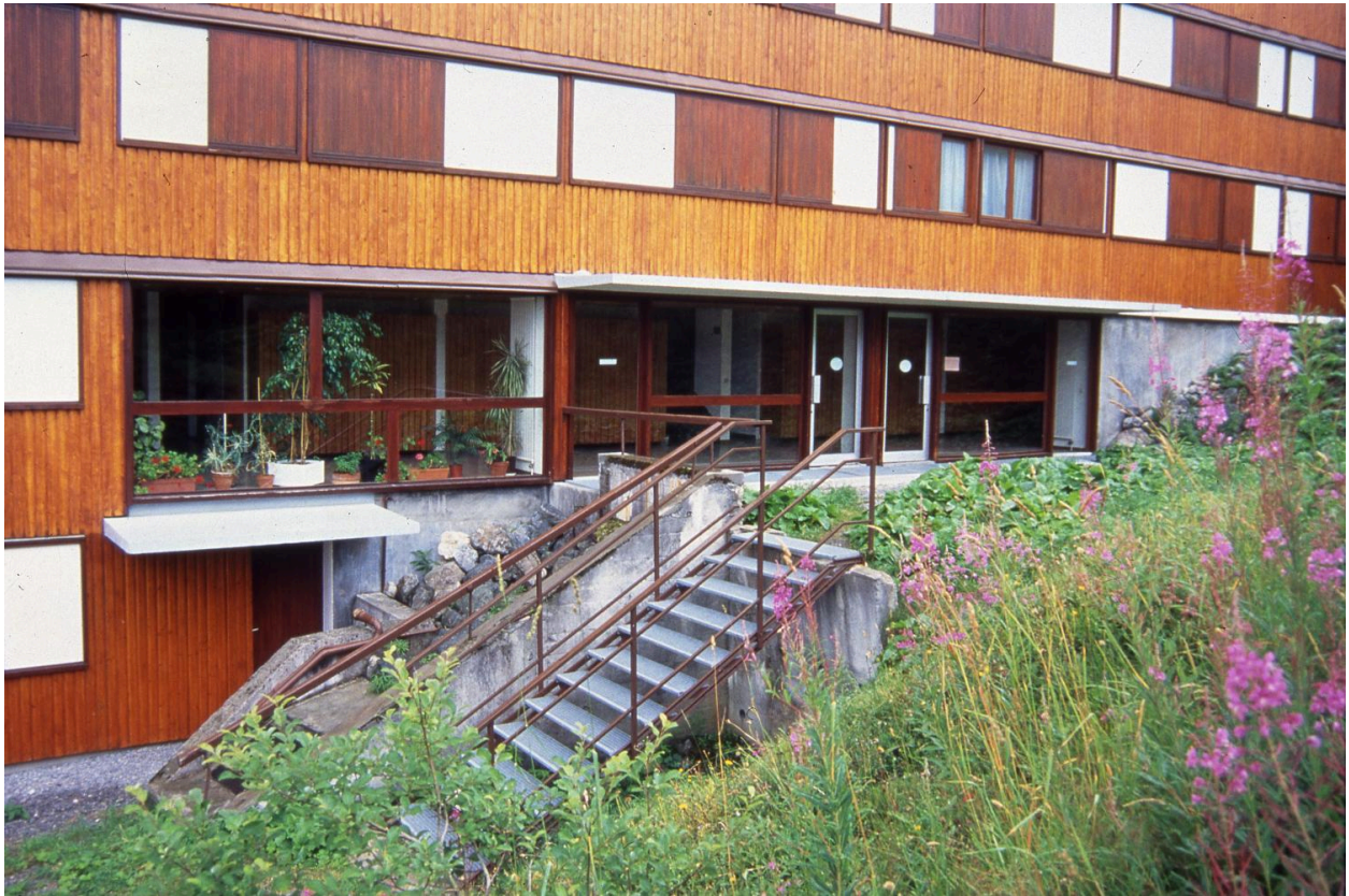
Elévation nord. Détail de l'entrée
