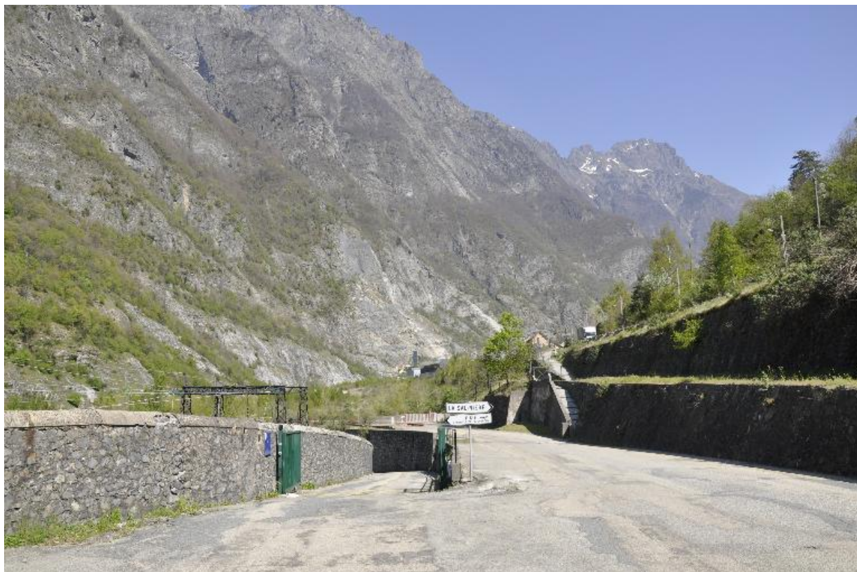
Vue de l'entrée de la centrale
