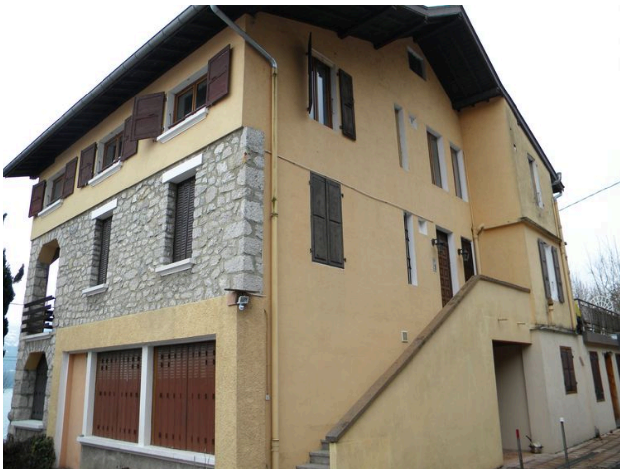
Vue de trois-quarts avec façade arrière.
