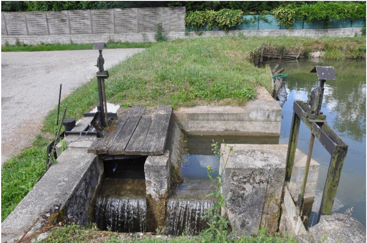
Détail de la vanne à l'extrémité de la réserve avec le déversoir de trop-plein, 2010.
