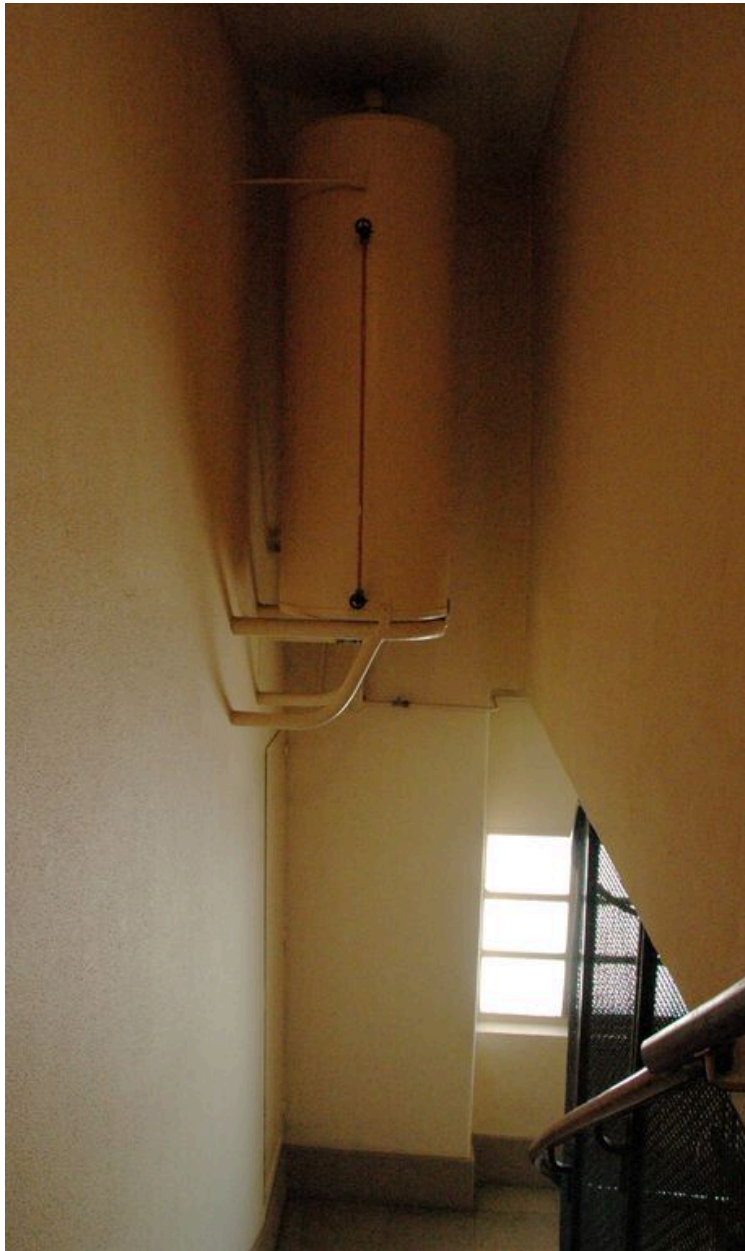
Vue du ballon d'eau du dernier étage
