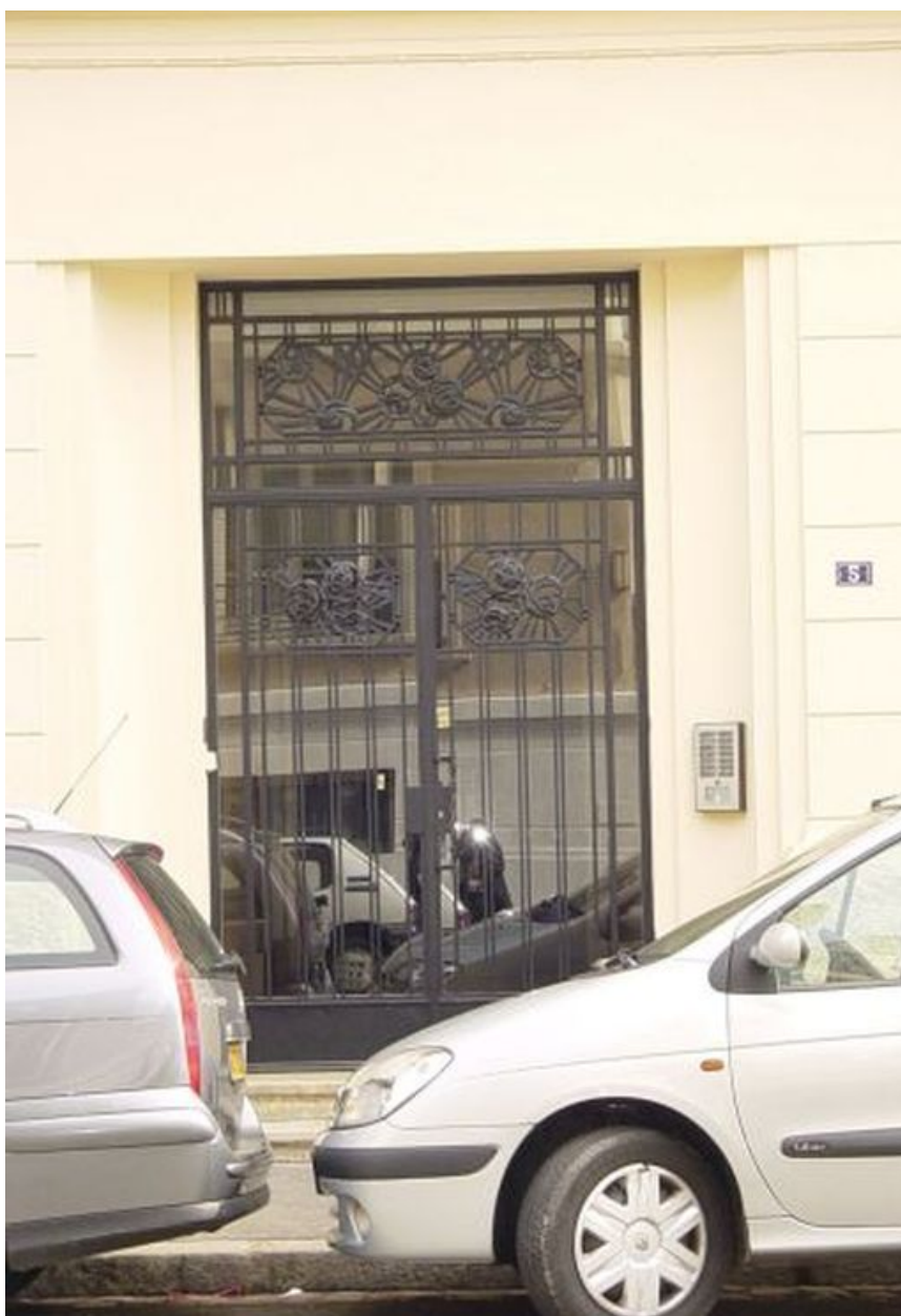
Vue extérieure de la porte d'entrée
