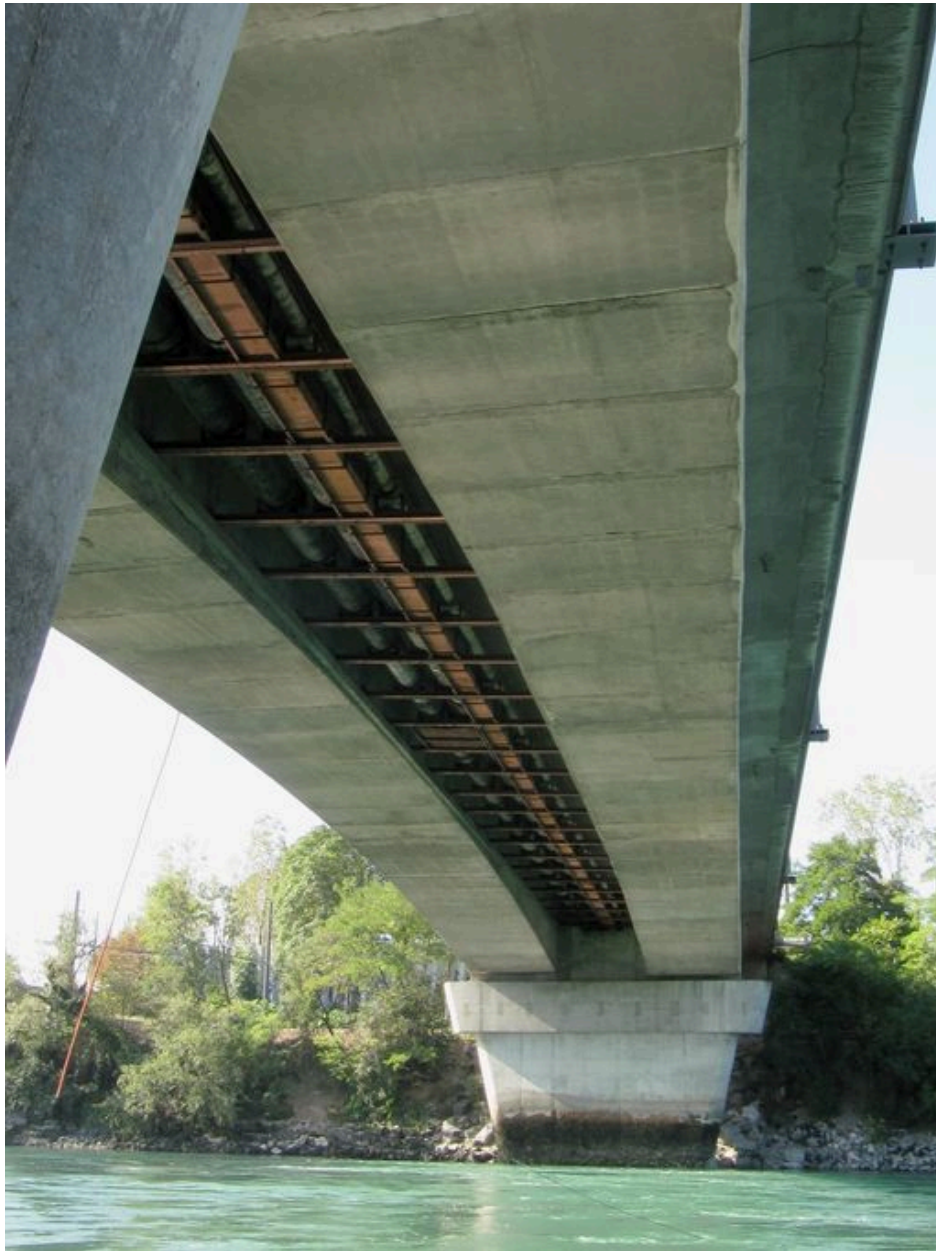
Tablier vu de dessous (depuis la rive droite)
