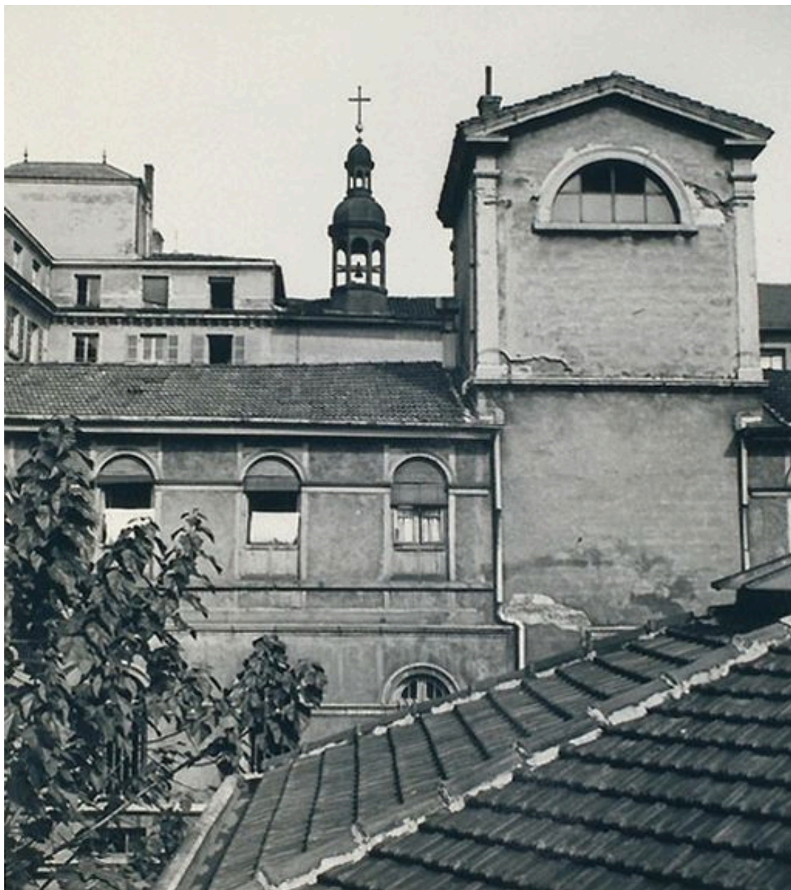
Cour de la Rotonde, toit de l'amphithéâtre, vue partielle de l'aile nord avec la tour du château d'eau, fotogr. ca 1930-1935
