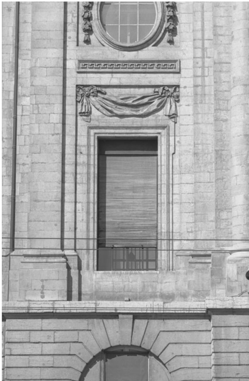
Elévation sur le quai du Rhône : draperie ornant une fenêtre. Photogr. 1978
