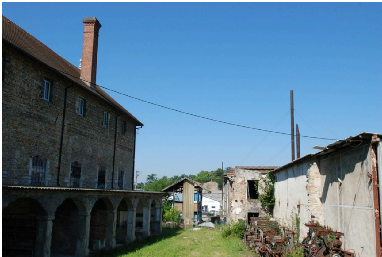
Façade nord de la forge
