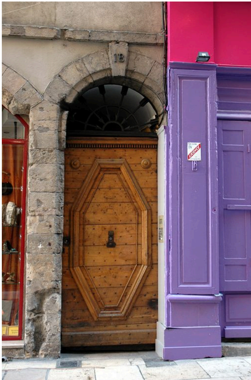
Elévation rue de la Monnaie : détail de la porte
