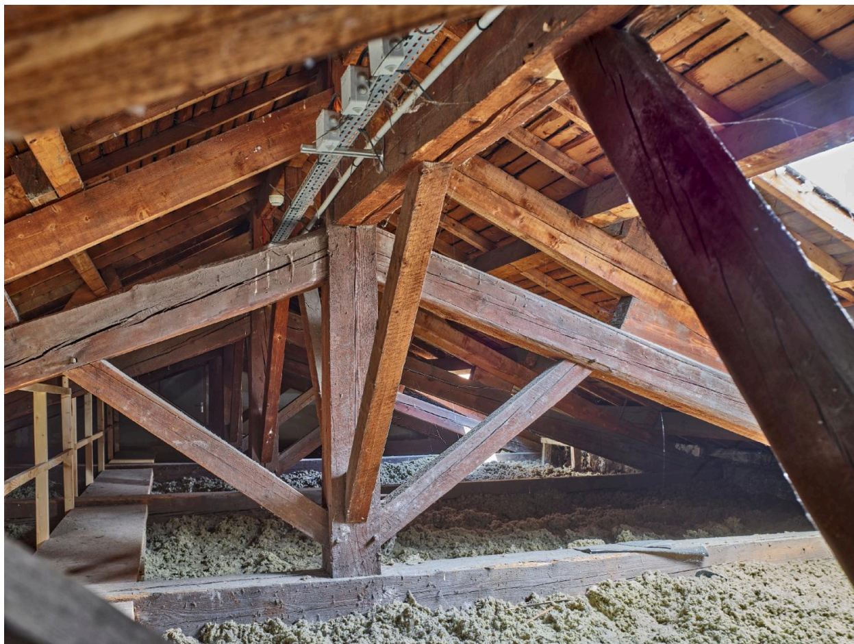
Bâtiment C, comble : détail de la charpente d'origine, surélevée afin d'accentuer la pente du toit
