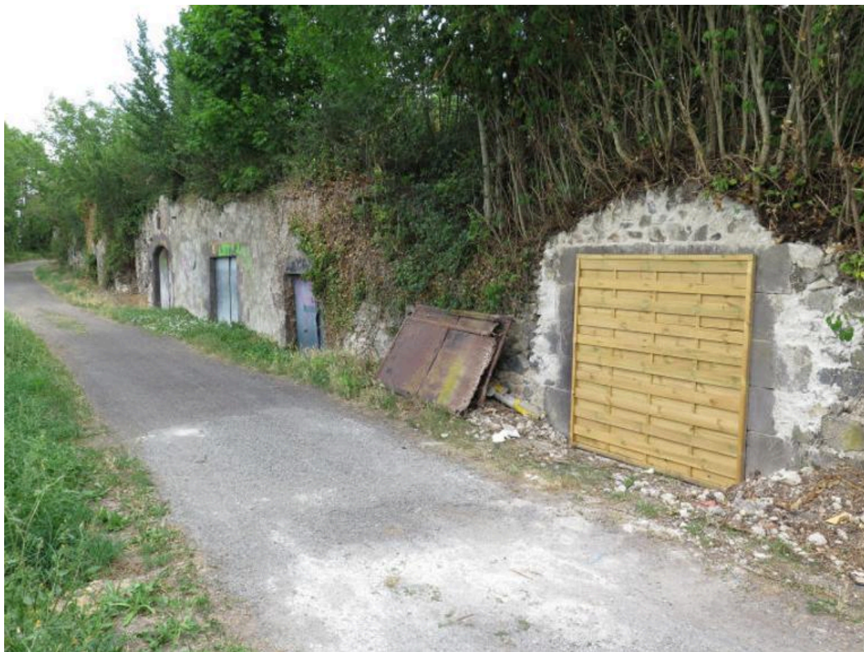
Ensemble de "caves" à Romagnat
