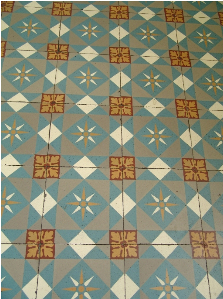
Appartement du 1er étage, sol en carreaux de ciment, détail
