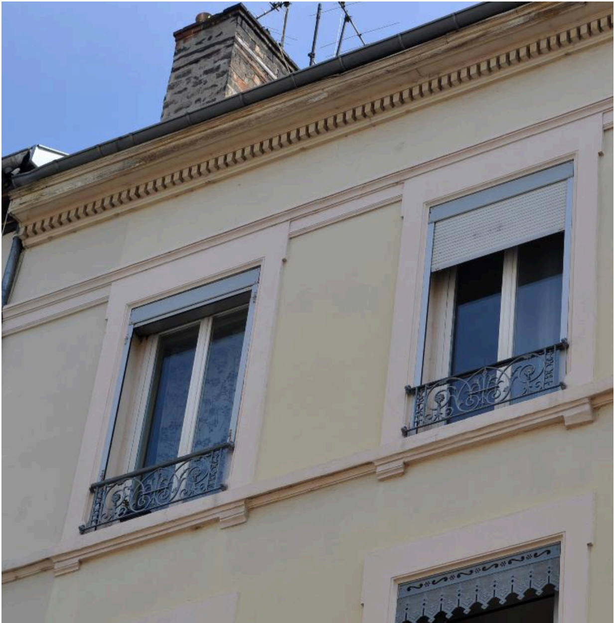
Immeuble, détail du couronnement de l'élévation sur rue
