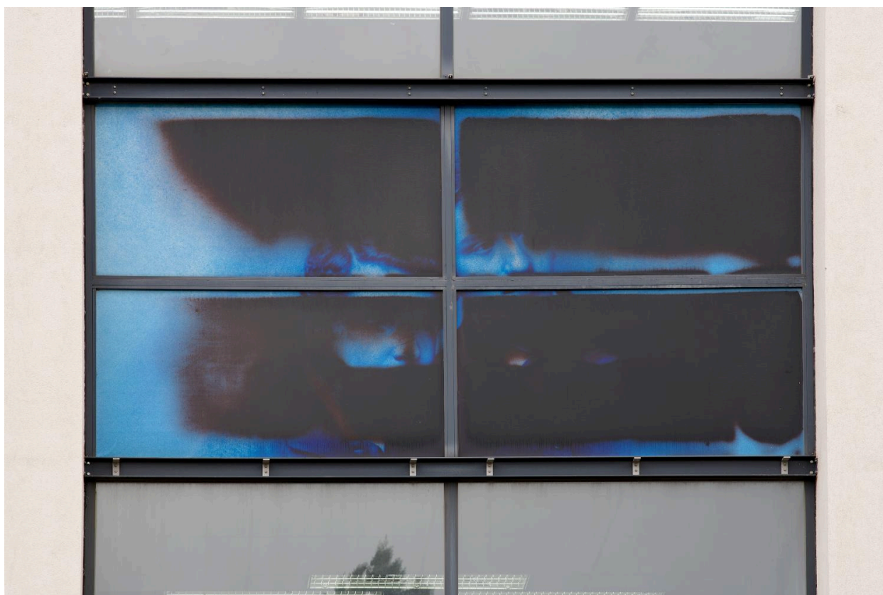
Photographie sur façade sur cour n° 2.
