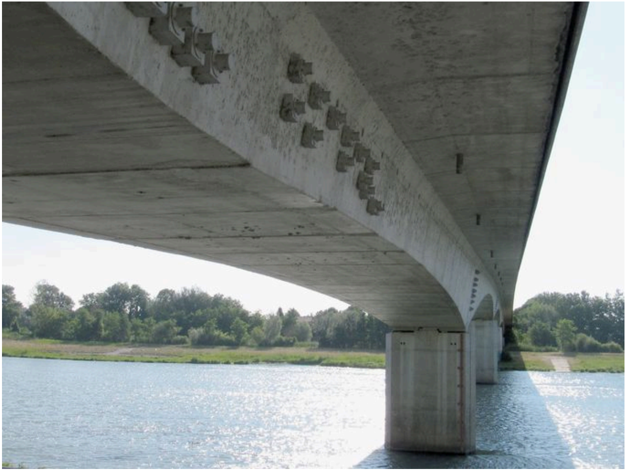
Vue partielle, de dessous, tablier et piles (depuis la rive droite)
