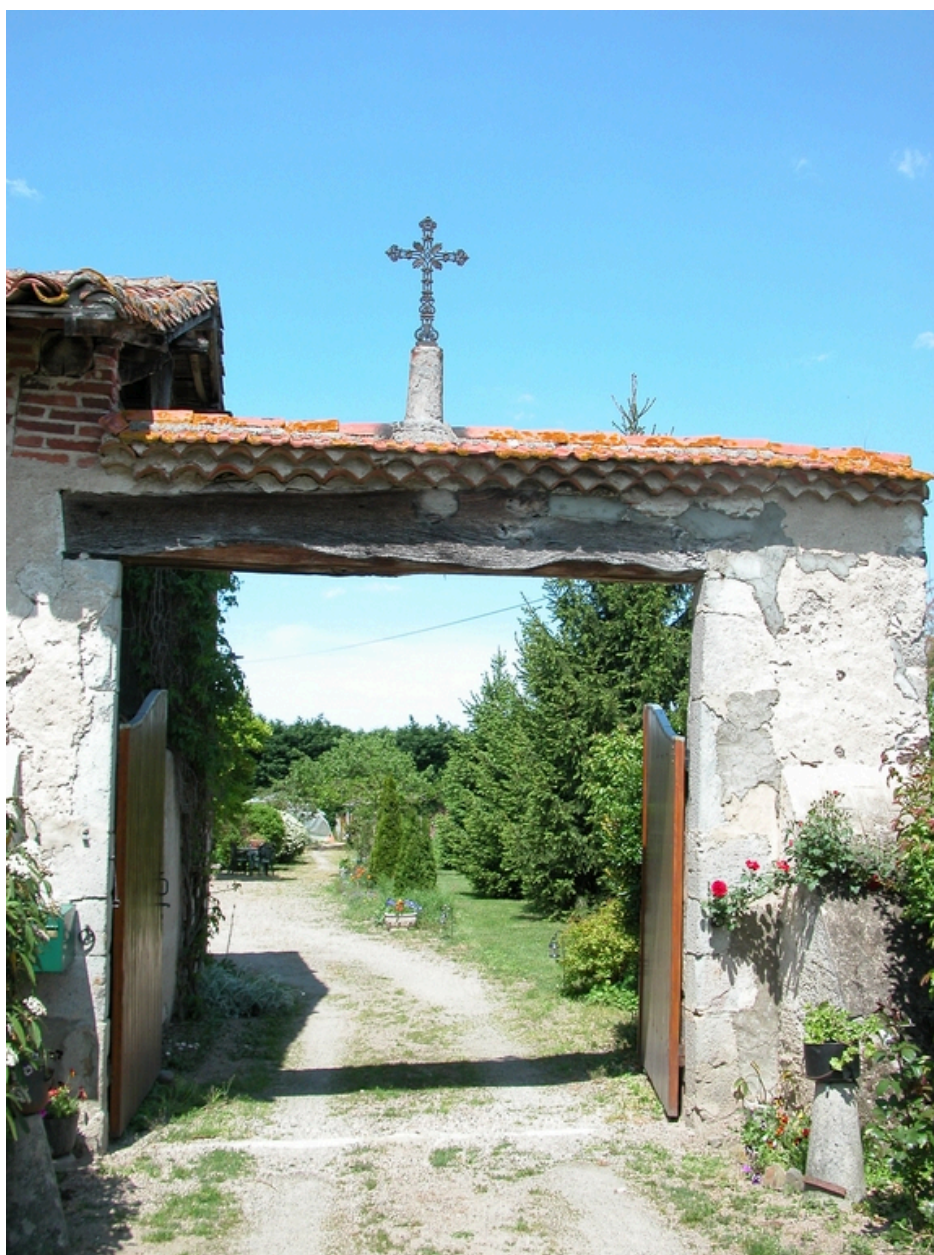
Vue du portail d'entrée (depuis la cour).
