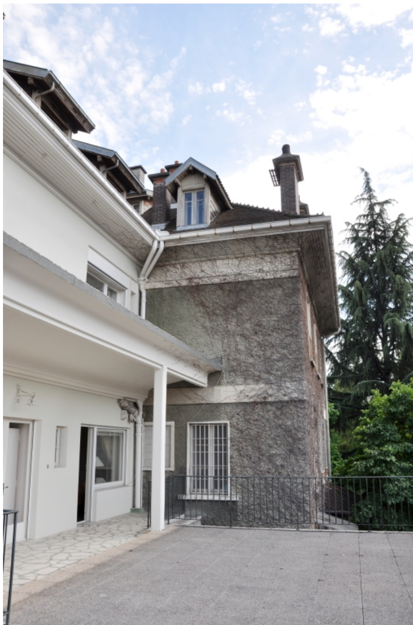
Terrasse du 1er étage sur façade ouest
