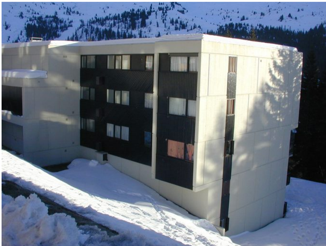
La partie occidentale depuis le nord-ouest
