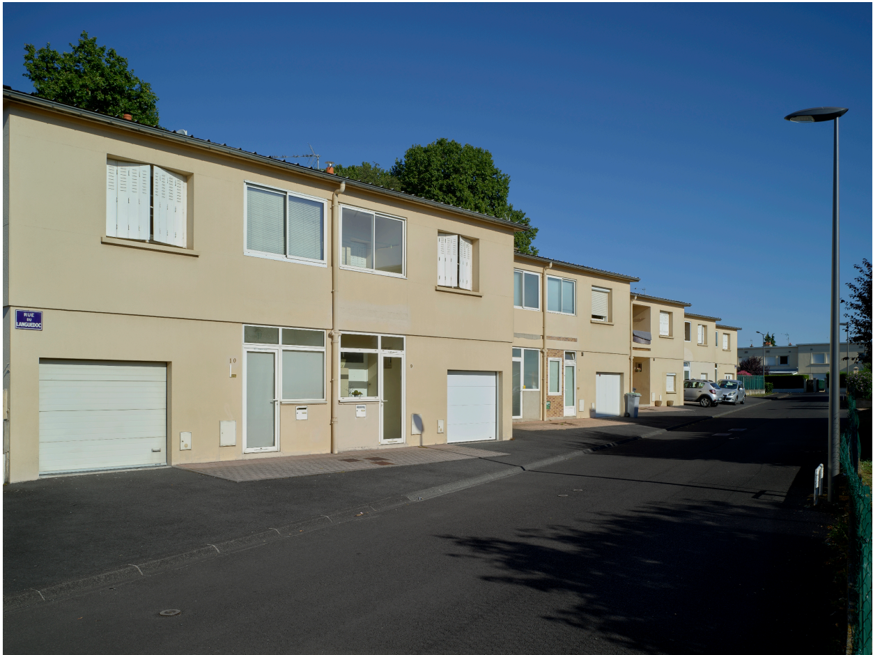
Ensemble de maisons accolées, avec décrochements, rue du Languedoc : élévations côté entrées.
