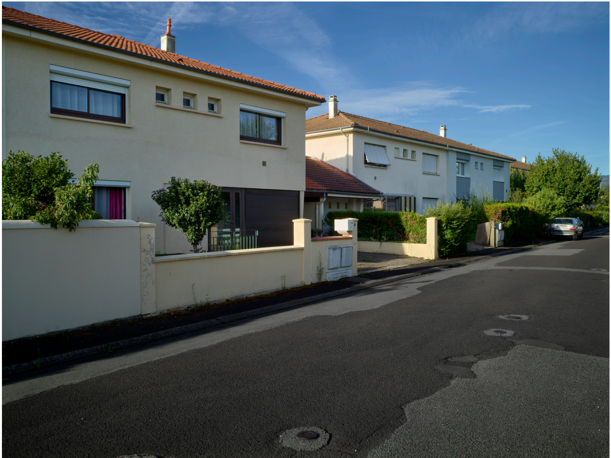
Deux maisons doubles accolées par l'intermédiaire de leurs garages, 1974-1975 (cité de Mozac).
