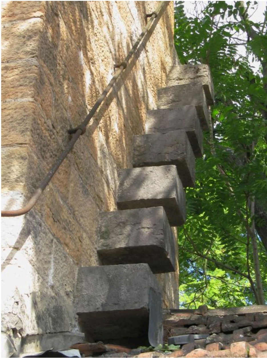
Pile droite, vue de détail : escalier et main-courante (depuis le sud)
