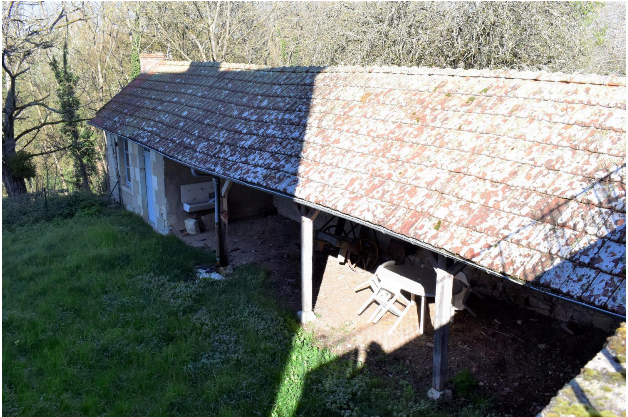
Vue générale du préau et de la pièce attenante à l'ouest;
