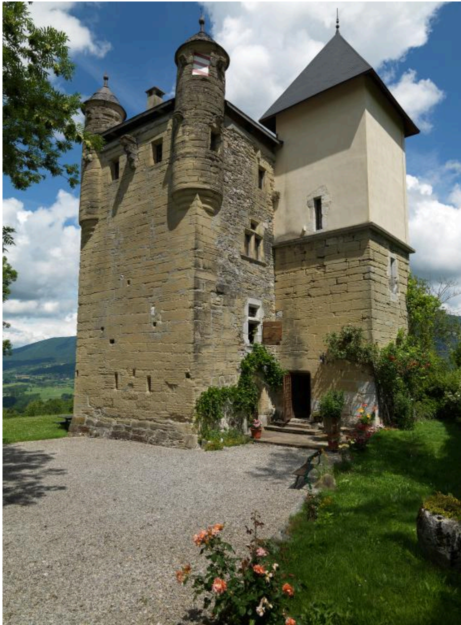
Vue d'ensemble de la maison forte de trois-quarts avant gauche.
