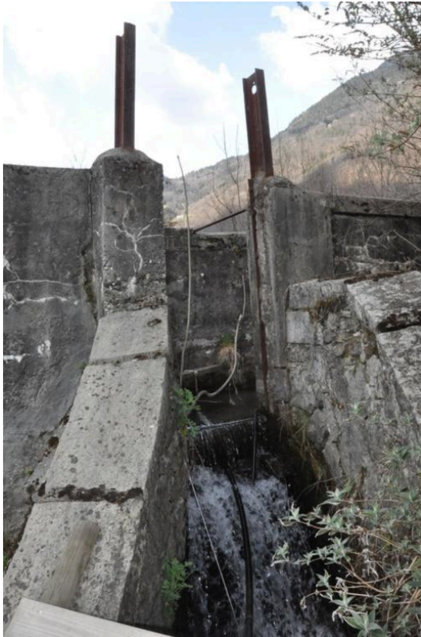
Vue du canal d'amenée.
