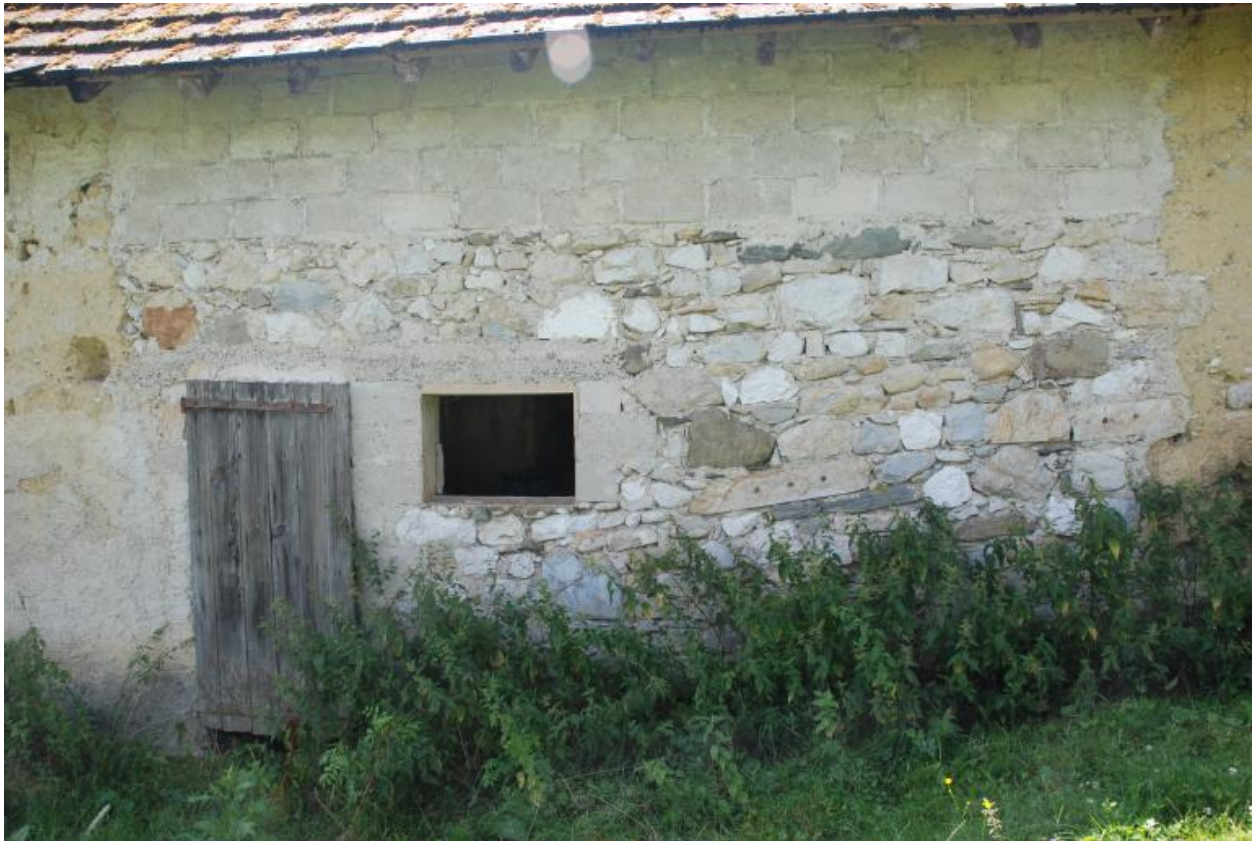
Détail de l'élévation postérieure : mur de l'étable.
