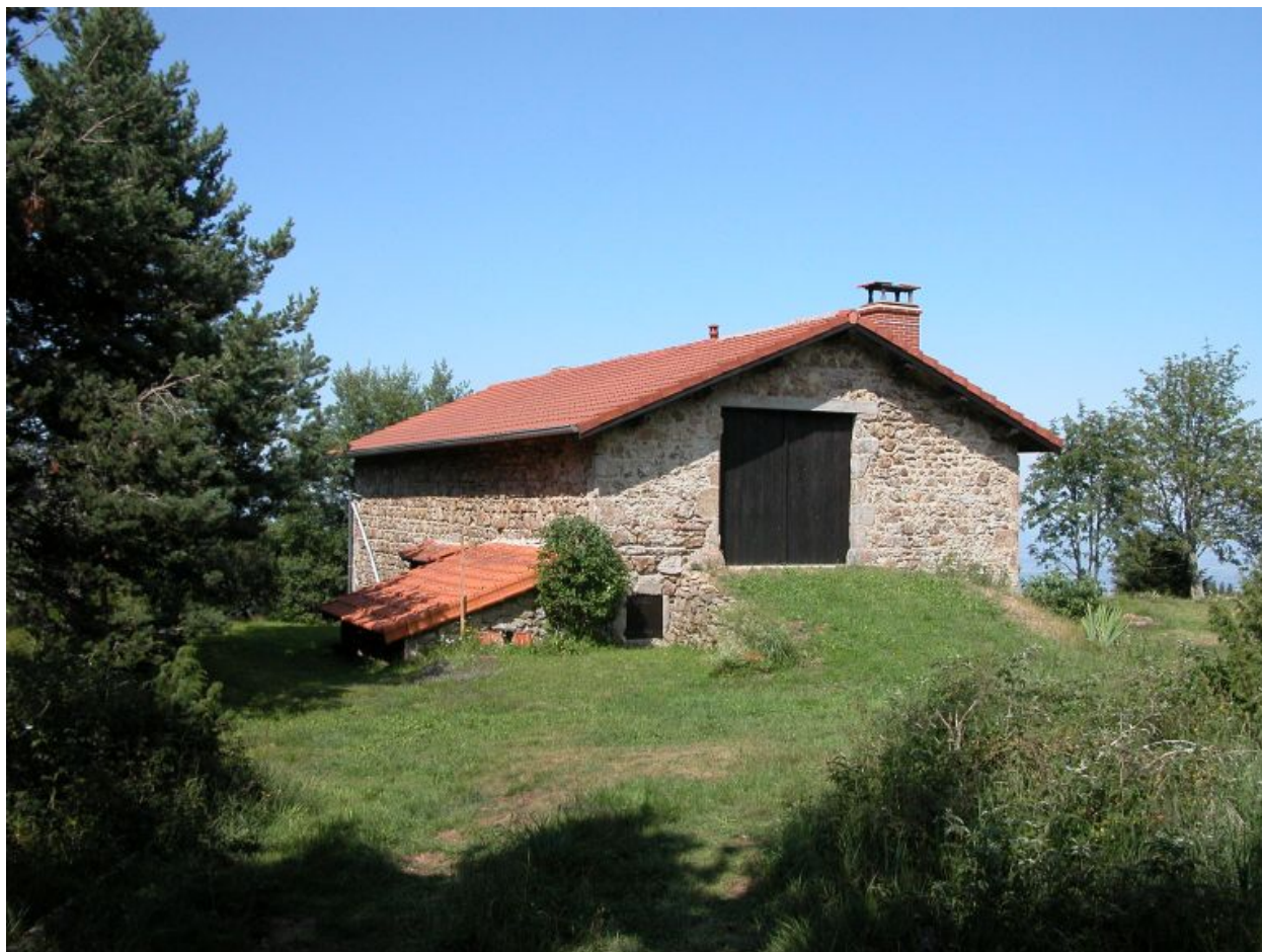
Vue d'ensemble de la jasserie depuis le sud-ouest.
