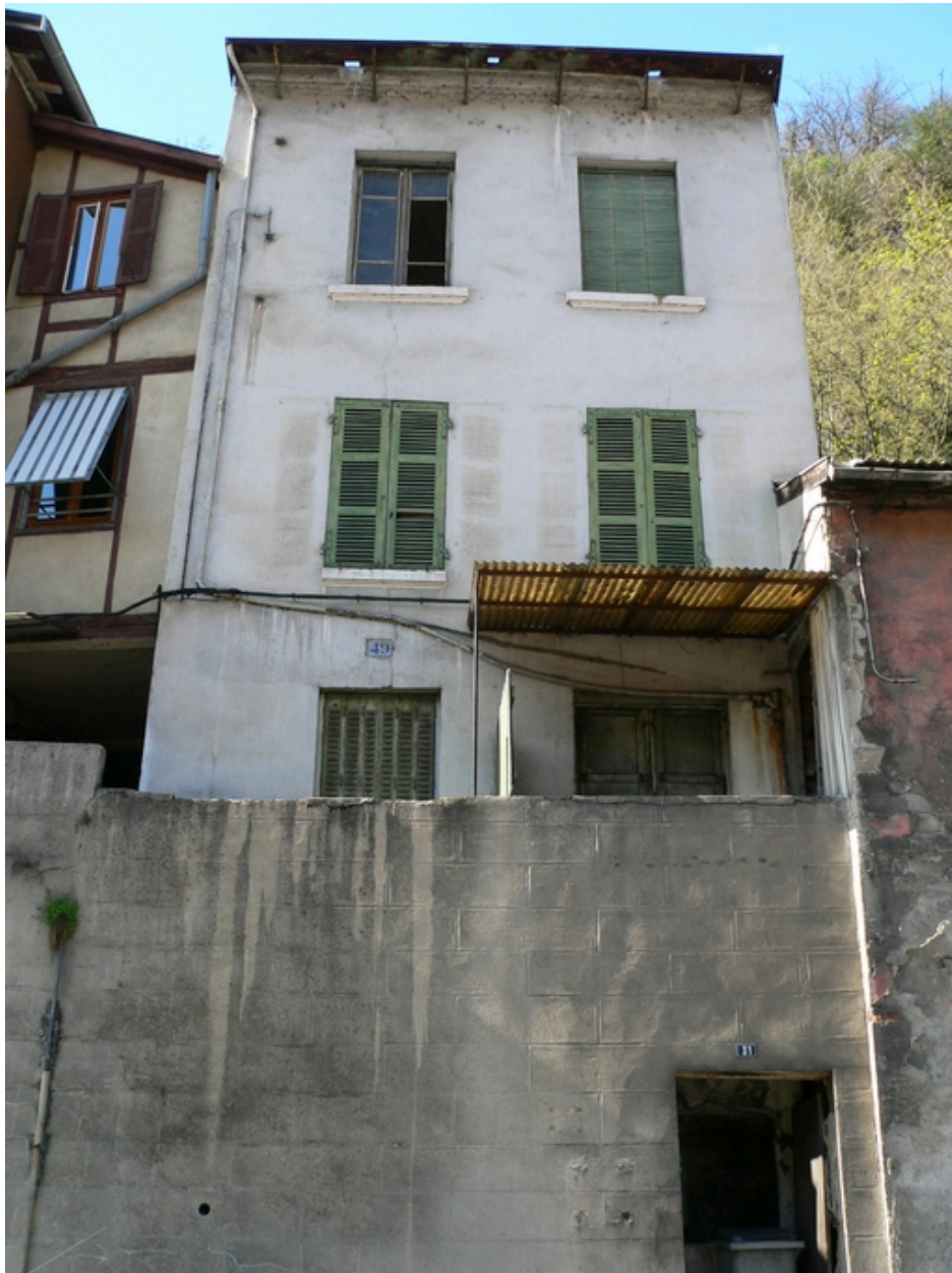
Façade principale sur rue
