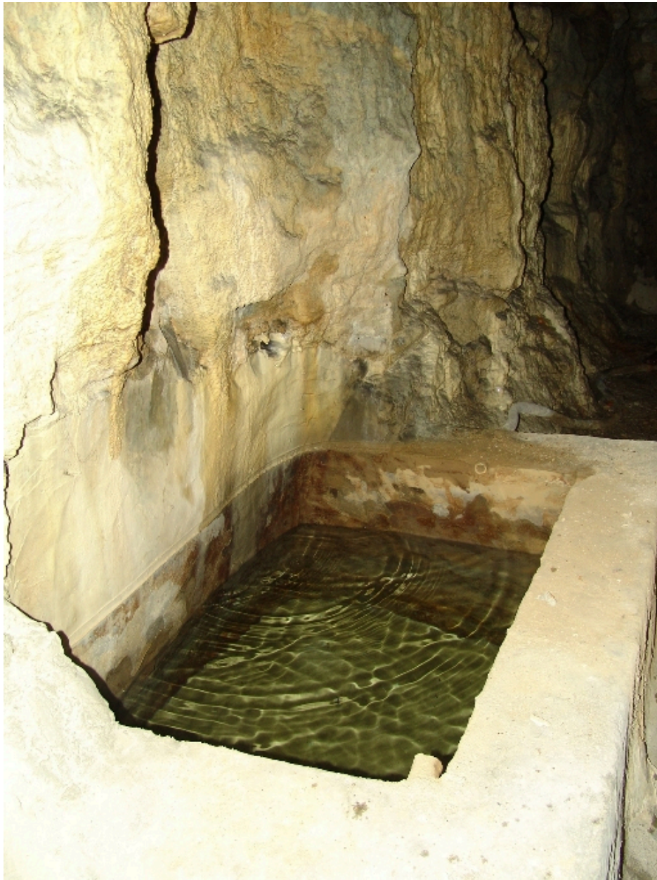
Bassin dans le dégagement souterrain autour de la maison
