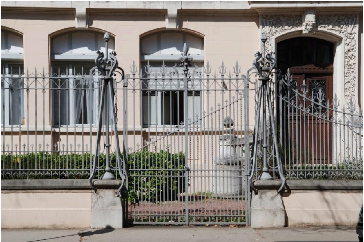
Elévation principale : portail
