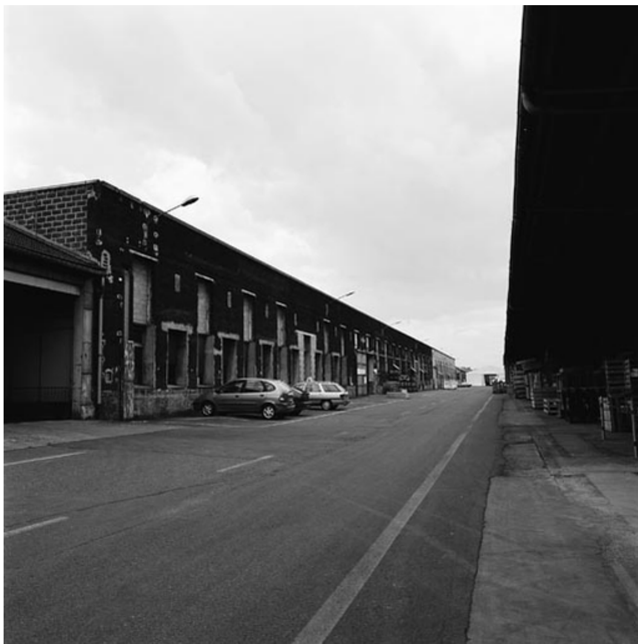
Fonderie, équipement électrique, CD0, avenue 5.
