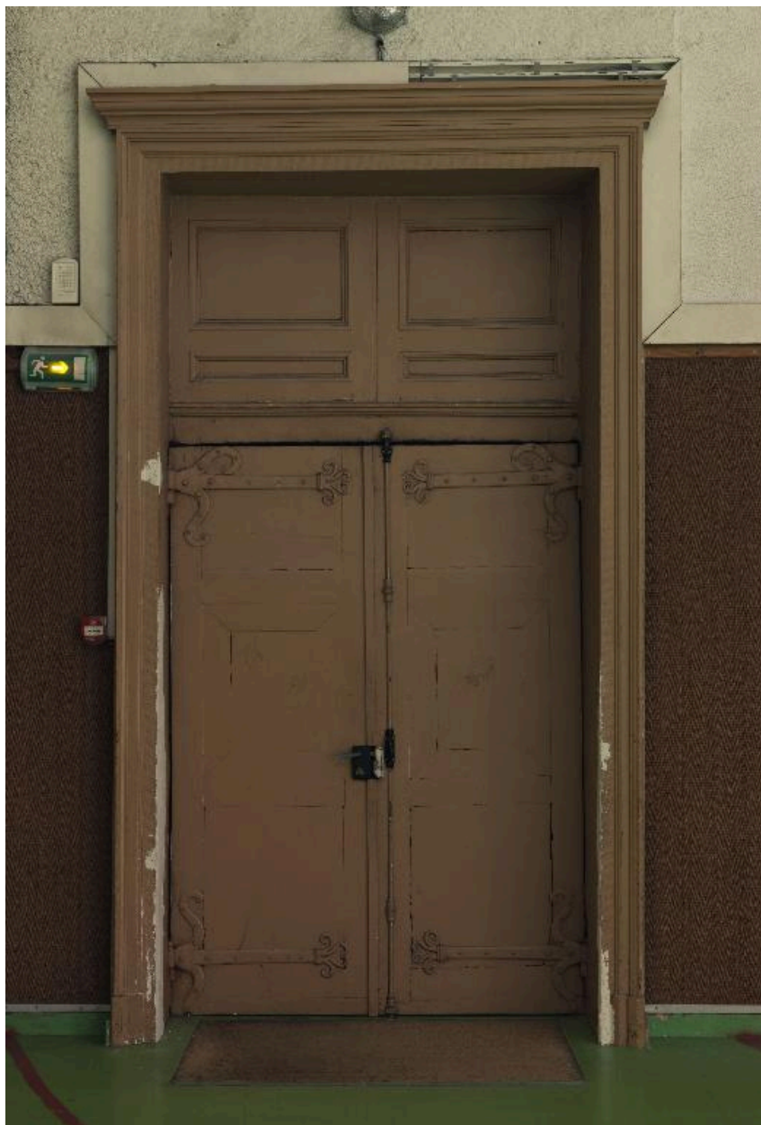
Porte d'entrée, vue depuis l'intérieur
