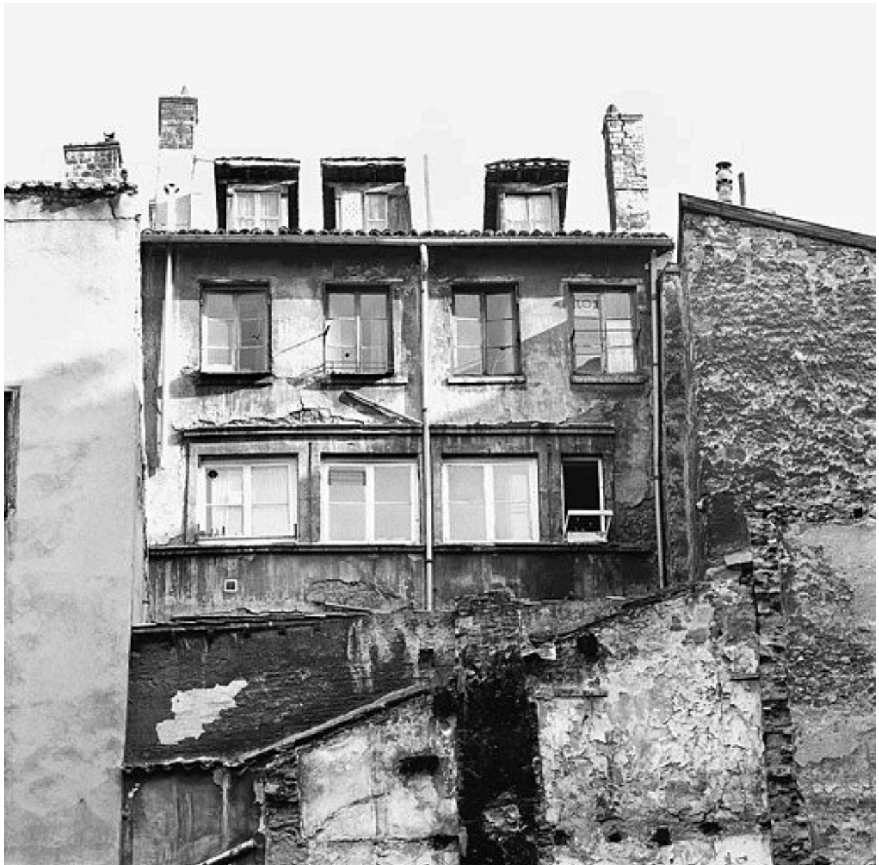
Partie supérieure de l'élévation donnant sur la cour
