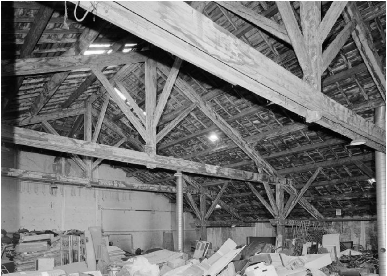
Vue du fenil depuis l'entrée
