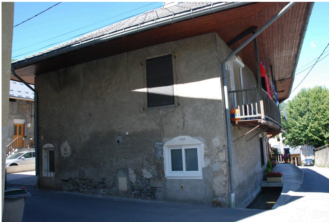
Impasse Taillanderie, vue de 2018 I1 175, élévation ouest et passage du bief.
