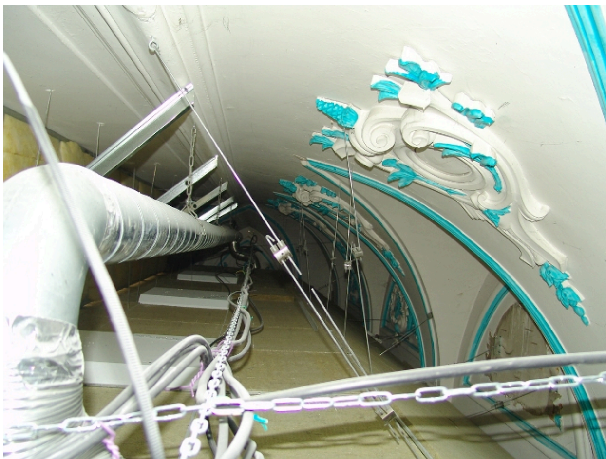
Accrochage du faux-plafond sur la voûte
