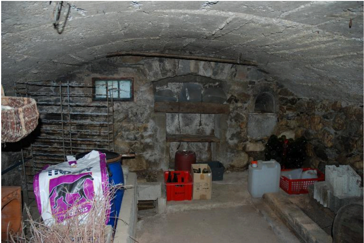
Vue intérieure de la cave.
