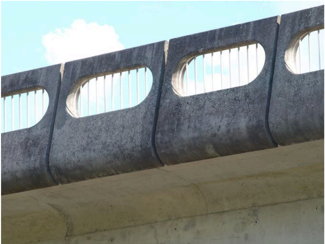
Parapet, vue partielle aval (depuis la rive droite)
