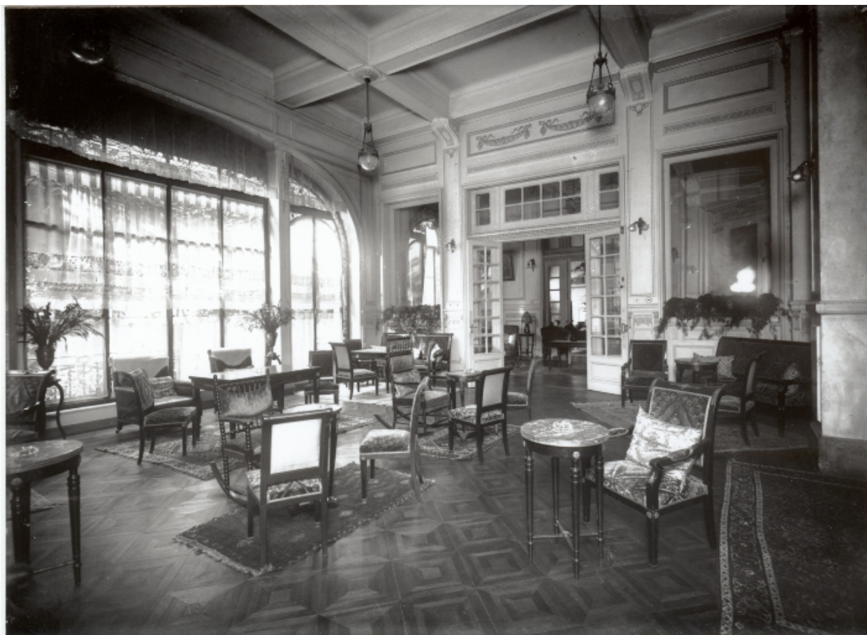
Le grand salon, verrière et mur droit
