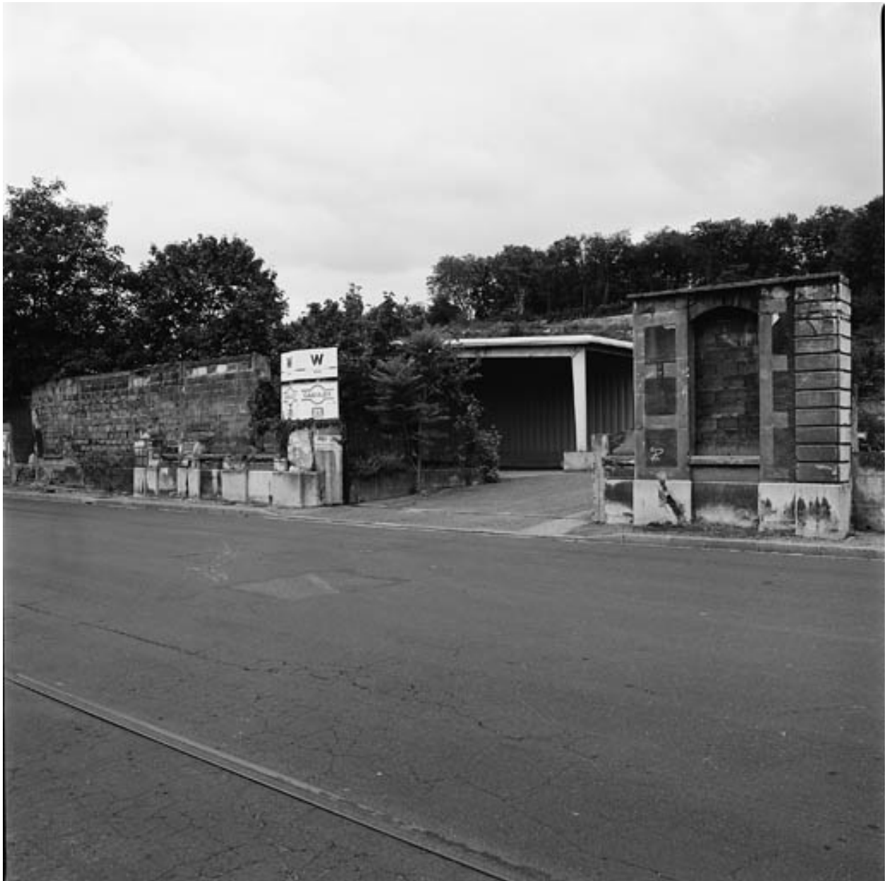
Traces de l'ancienne entrée sur le mur de façade
