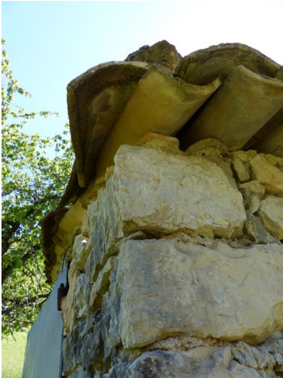
Elévation nord, avant-toit constitué du débord des tuiles.
